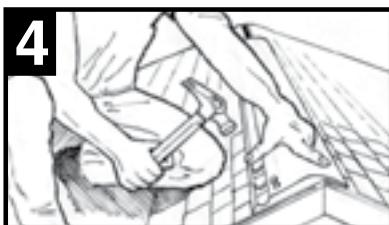
Aplique el respiradero de modo que la bisagra esté centrada a lo largo del pico permitiendo que el reborde descance en la cubierta del techo (**vea la vista 4a**) frente a la abertura de la ranura. Fije el cuerpo del respiradero del techo usando clavos para tejados de vástago anillado de 2.5" y clavando a través de los (2) orificios pilotos del cuerpo del respiradero.
